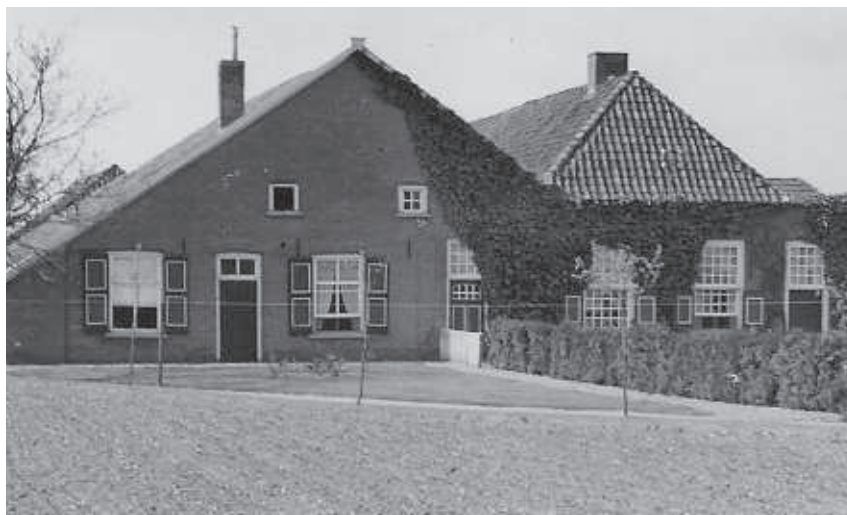
Schoolhuis met aangebouwde vaaltstal
